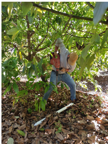
Instalação de sondas – abacateiros
